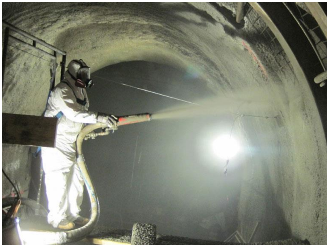
Рисунок 8 – Набрызгивание бетона
