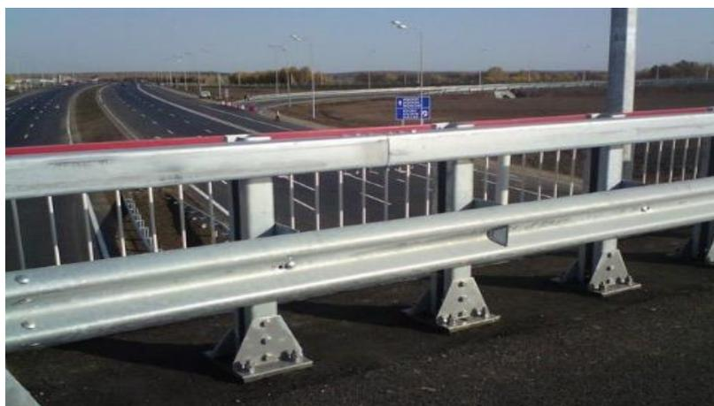
Рисунок 1 – Мостовое ограждение
