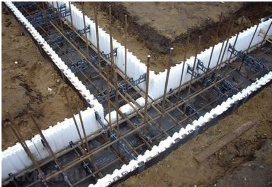
Рисунок 11 – Несъемная опалубка из пенополистирола
