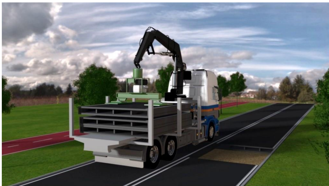
Рисунок 6 – Монтаж секций пластиковой дороги
