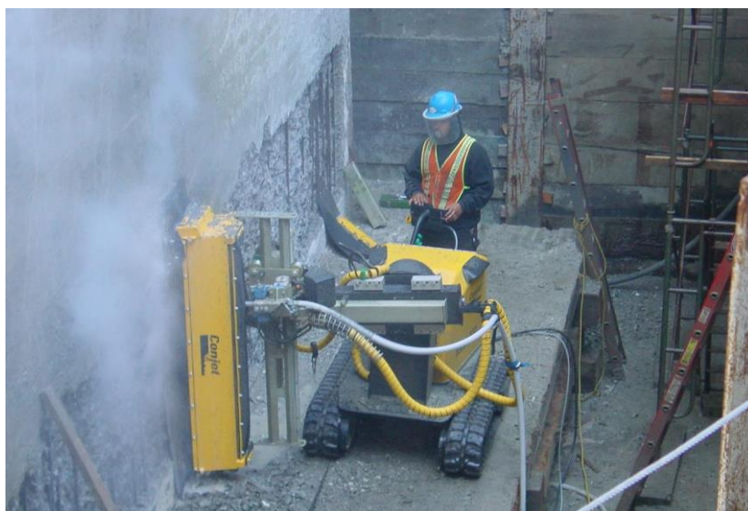
Рисунок 2- Применение технологии гидроразрушения при реконструкции тоннеля
