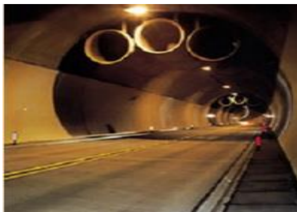
Рисунок 10 – Продольная вентиляция
