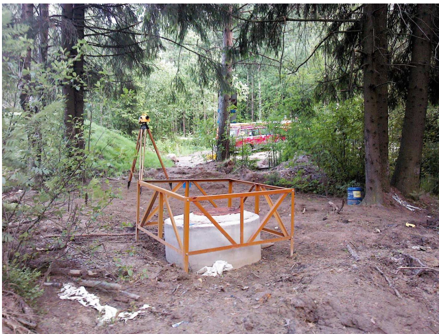
Рис. 4. Новый заложенный фундаментальный репер. Внешний вид
