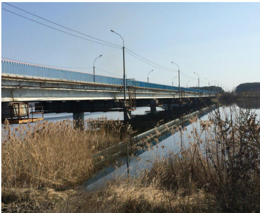
Рис. 1.6 – Автомобильный мост через Солигорское водохранилище
