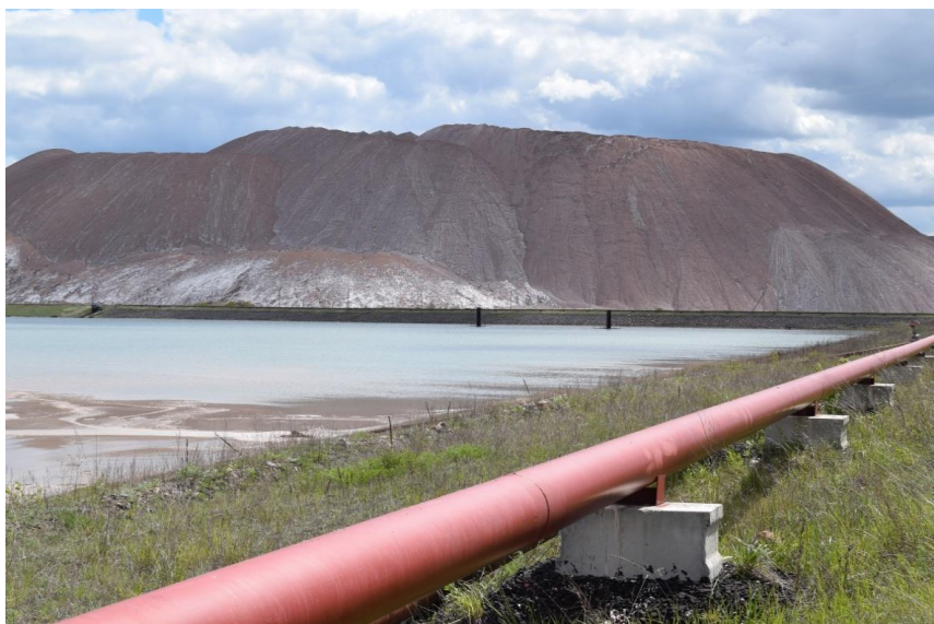
Рис. 1.4 – Ограждающая дамба шламохранилища ДЗ
