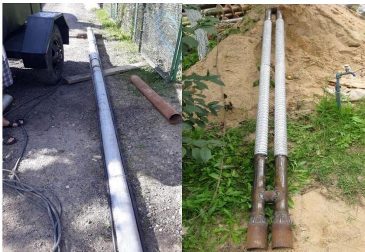
Рис. 2 – Типовая и двухколонная фильтровые колонны перед спуском в стволы
