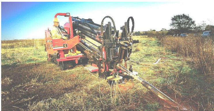
Рис. 2 –Установка горизонтального направленного бурения
