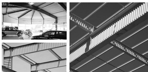
Рис. 10. Гофрированные балки в конструкции покрытия
