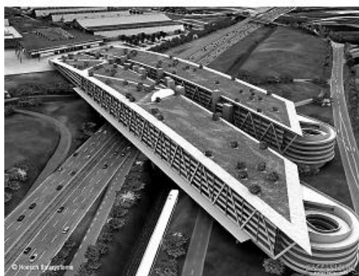
Рис. 37. Гараж-мост. Металлические несущие конструкции. ФРГ
