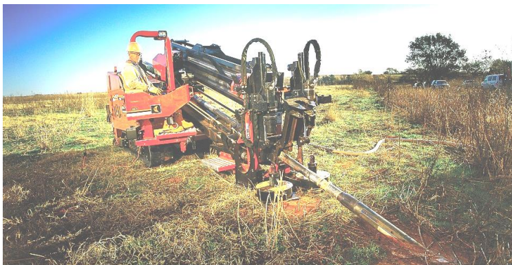
Рис. 2 –Установка горизонтального направленного бурения
