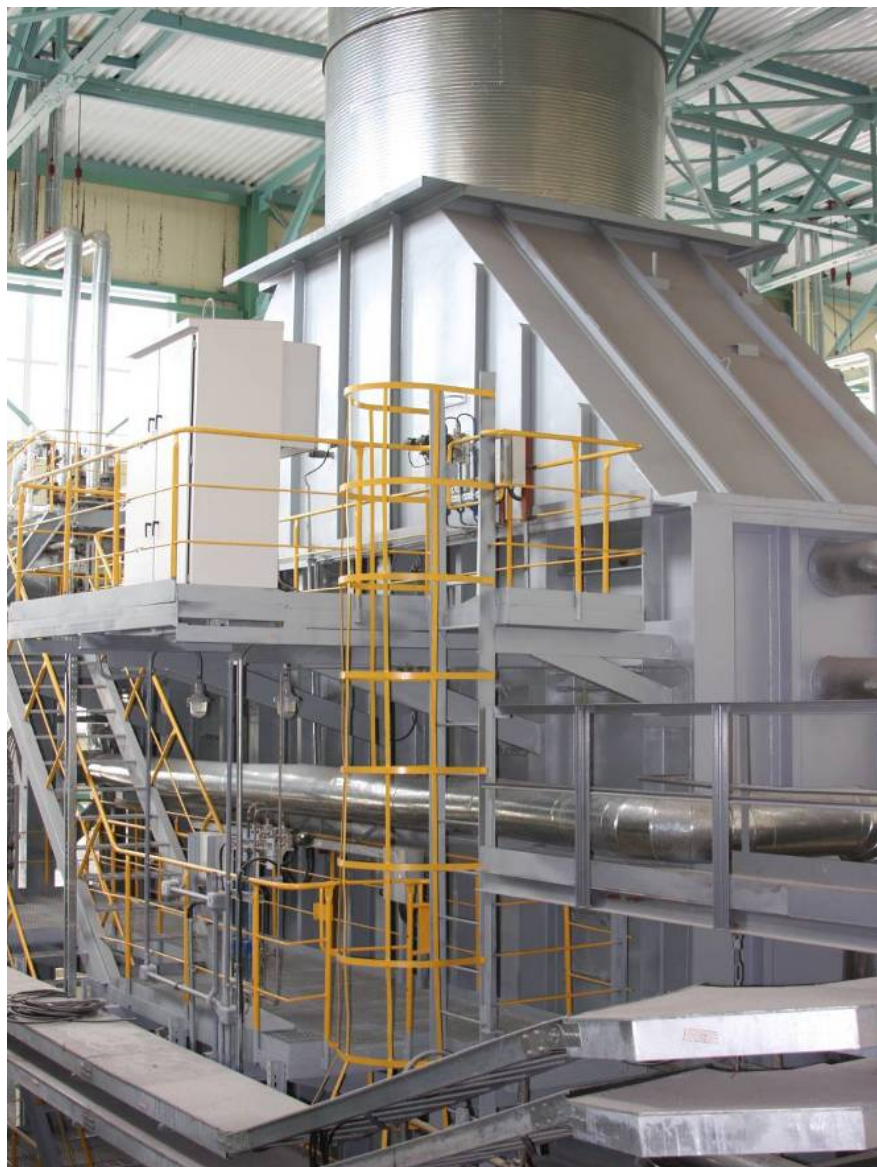
Рисунок 1 – Котел-утилизатор Q-235/541-32-3,6/435
