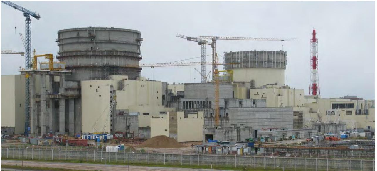
Рисунок 5.22. Строительство главных корпусов и реакторных отделений Белорусской АЭС
