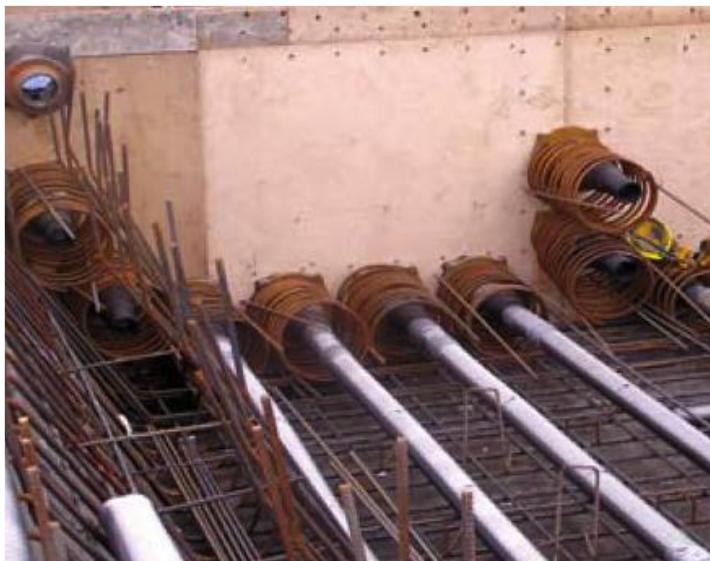
Рис. 4 – Опорные стаканы и спирали косвенного армирования
