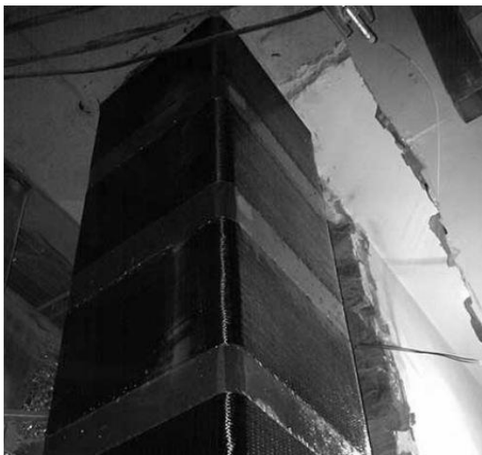
Рис. 2 – Усиление железобетонной колонны углеволокном
