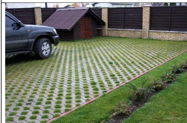
Рисунок 5. Эко-покрытие пропускает ливневые воды и земля не вымирает
