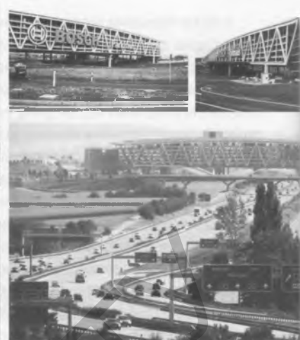
Рис. 8. Многоуровневая парковка-мост Neue Messe в Штутгарте
