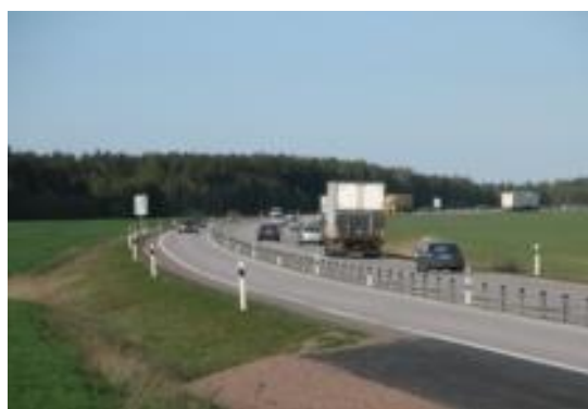
Рисунок 1 – Гибкое тросовое ограждение на дороге в Швеции
