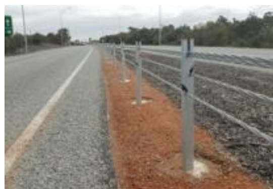
Рисунок 2 – Защитная барьерная тросовая система TL-3 и TL-4
