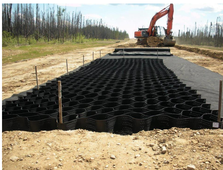
Рисунок 1 – Объемная георешетка в основании автомобильной дороги
