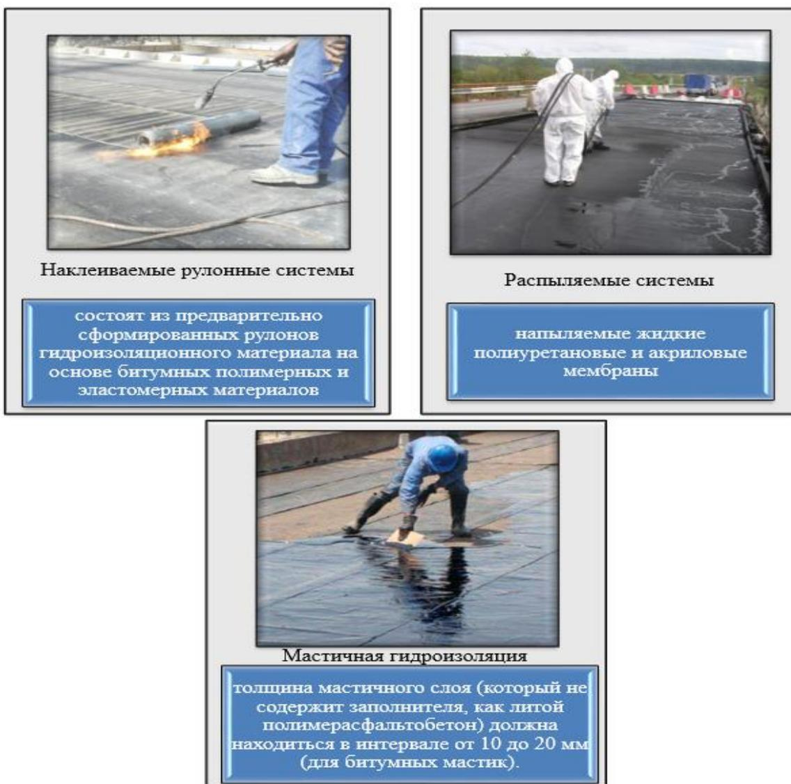
Рисунок 2 – Три основных типа гидроизоляции
