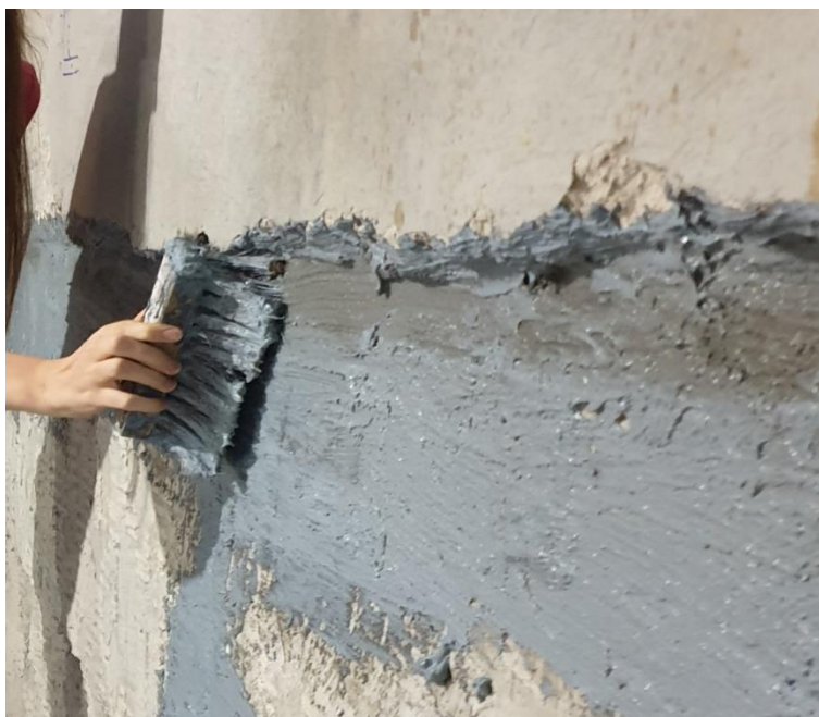
Рисунок 2 – Нанесение 2К Multi-Baudicht
