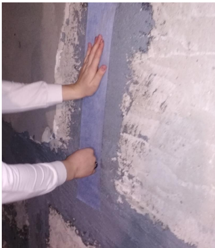
Рисунок 6 – Использование шовной ленты FUGENBAND VF120/VF500
