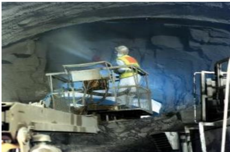
Рисунок 2 – распыление гидроизоляции Cormix
