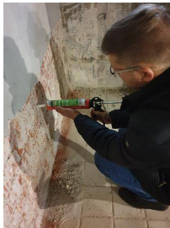
Рисунок 3 – Инъектирование состава
