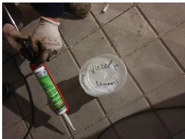
Рисунок 5 – Пистолет для герметиков
