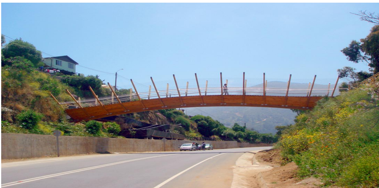
Рисунок 1 – вид моста сбоку
