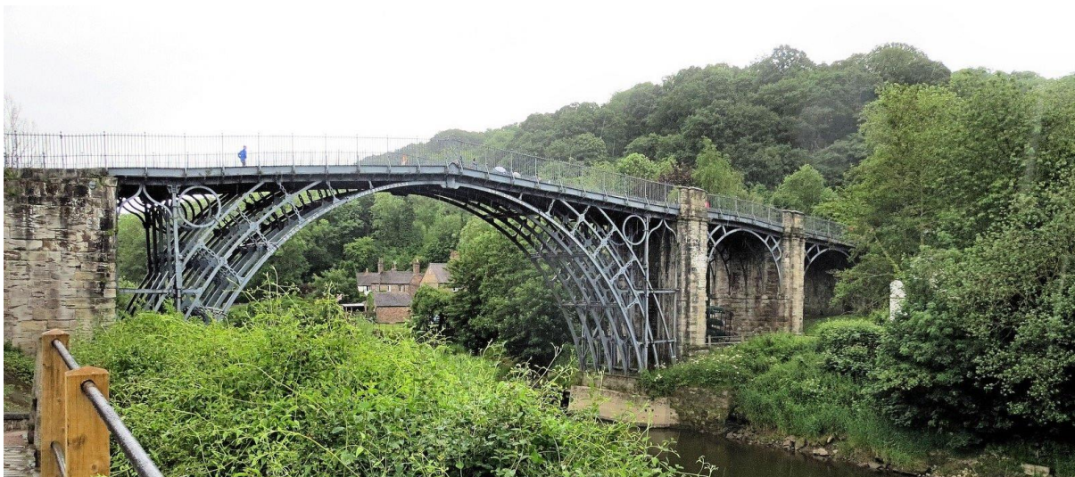
Рисунок 2 – Мост через реку Северн (Великобритания)
