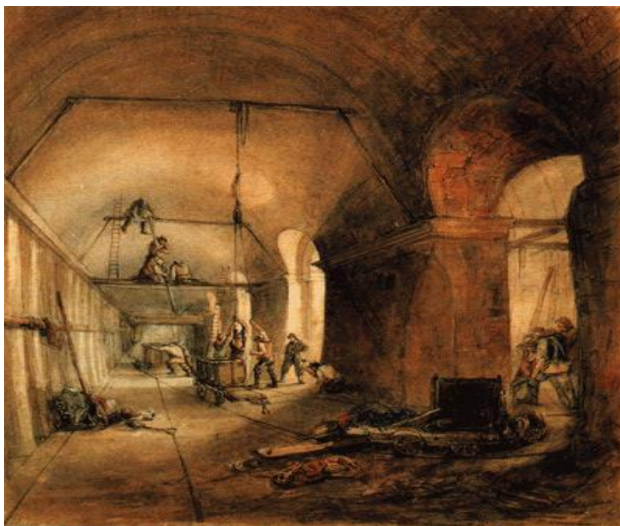
Рисунок 1 – Строительство тоннеля под р. Темза
