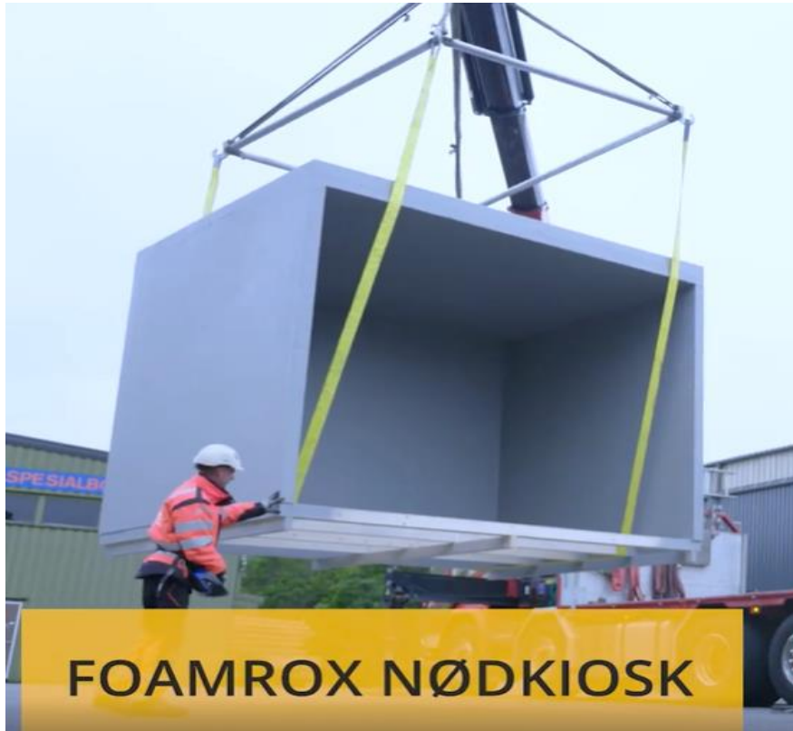
Рисунок 2 — Подготовка к перевозке конструкции из материала Foamrox
