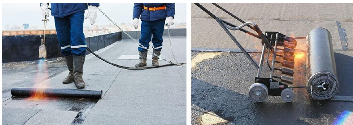
Рисунок 2 – Наплавление гидроизоляции
