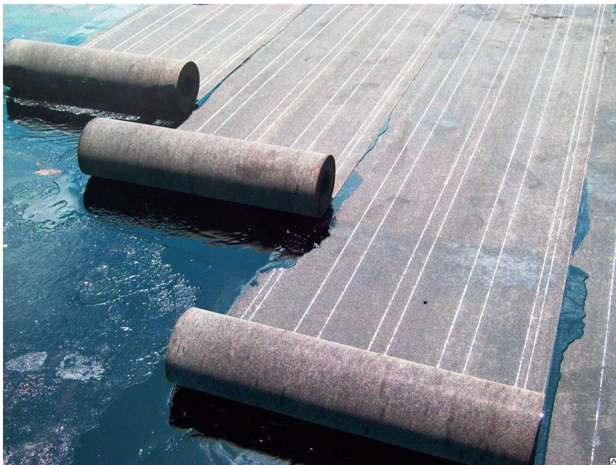
Рисунок 1 – Рулонная наплавливаемая гидроизоляция
