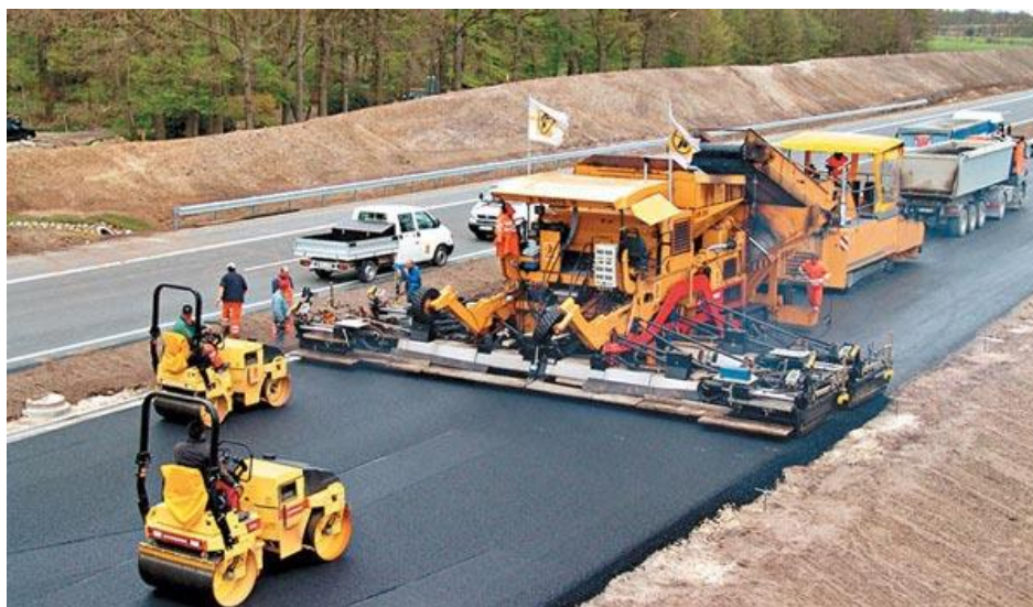
Рисунок 1 – Укладка бесшумного асфальта
