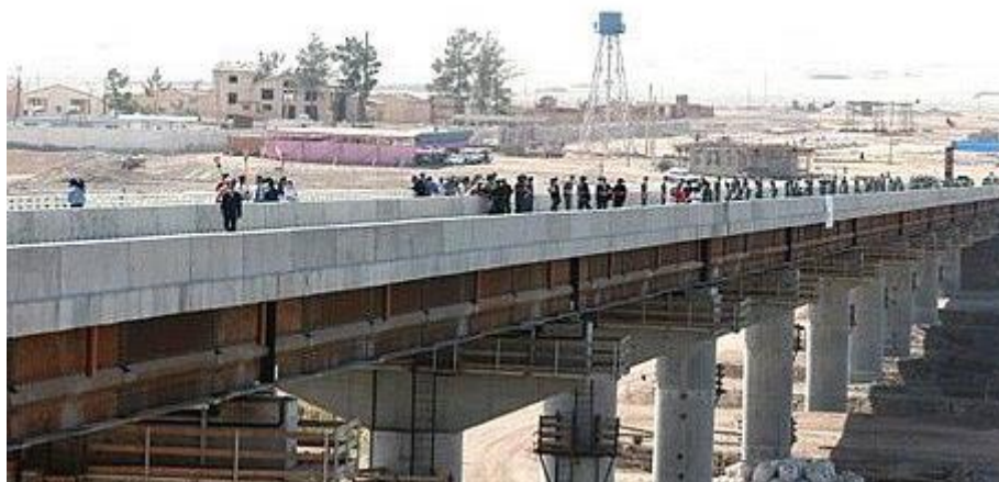
Рисунок 2 – Завершение строительства моста, 26 августа 2007 года
