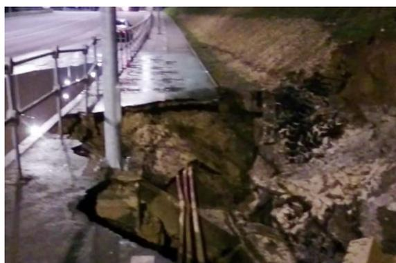
Рисунок 3 – Обрушения тротуарной зоны после ливневых дождей
