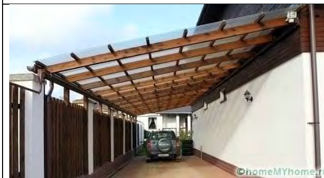
Рисунок 9. Построенный с северо-западной стороны навес защищает стену дома от косога дождя, а кустарник загораживает от ветра, но не заслоняет от солнца
