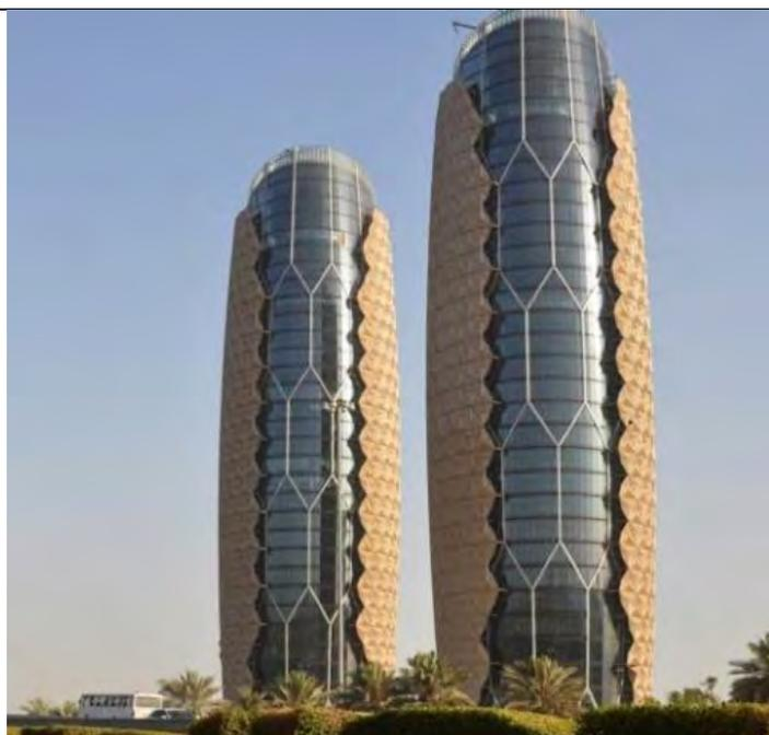
Рисунок 4. Динамические конструкции башен Al Bahg в ОАЭ
