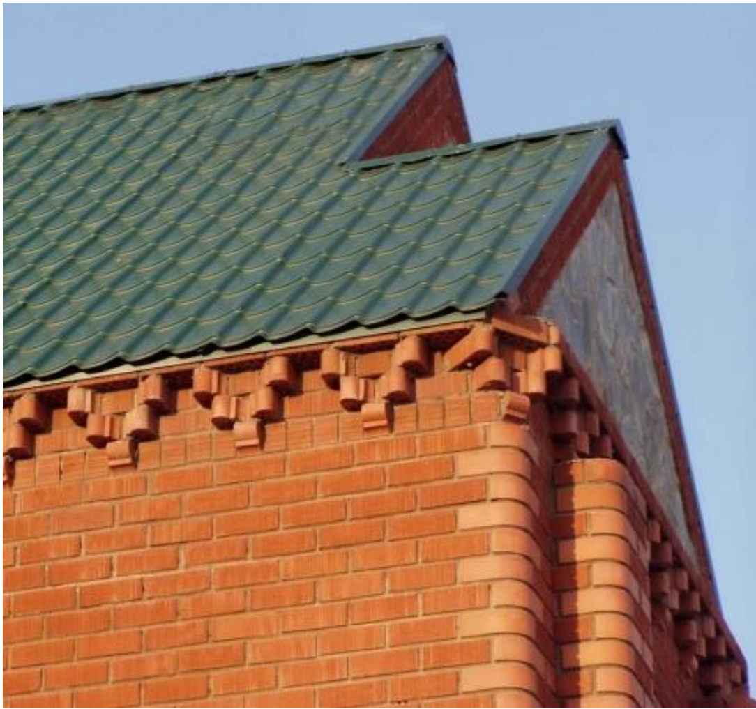
Рисунок 15.12 Сооружение из велюрового кирпича
