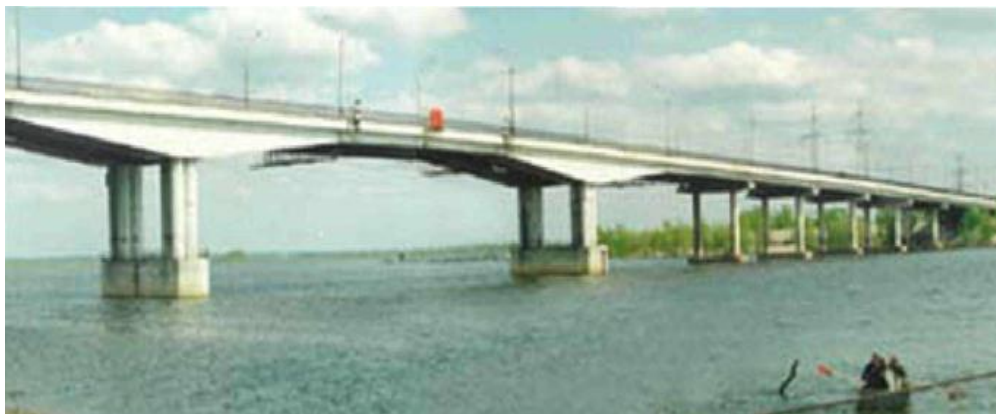
Рисунок 8.3 Рамно-подвесной железобетонный мост через реку Самару
