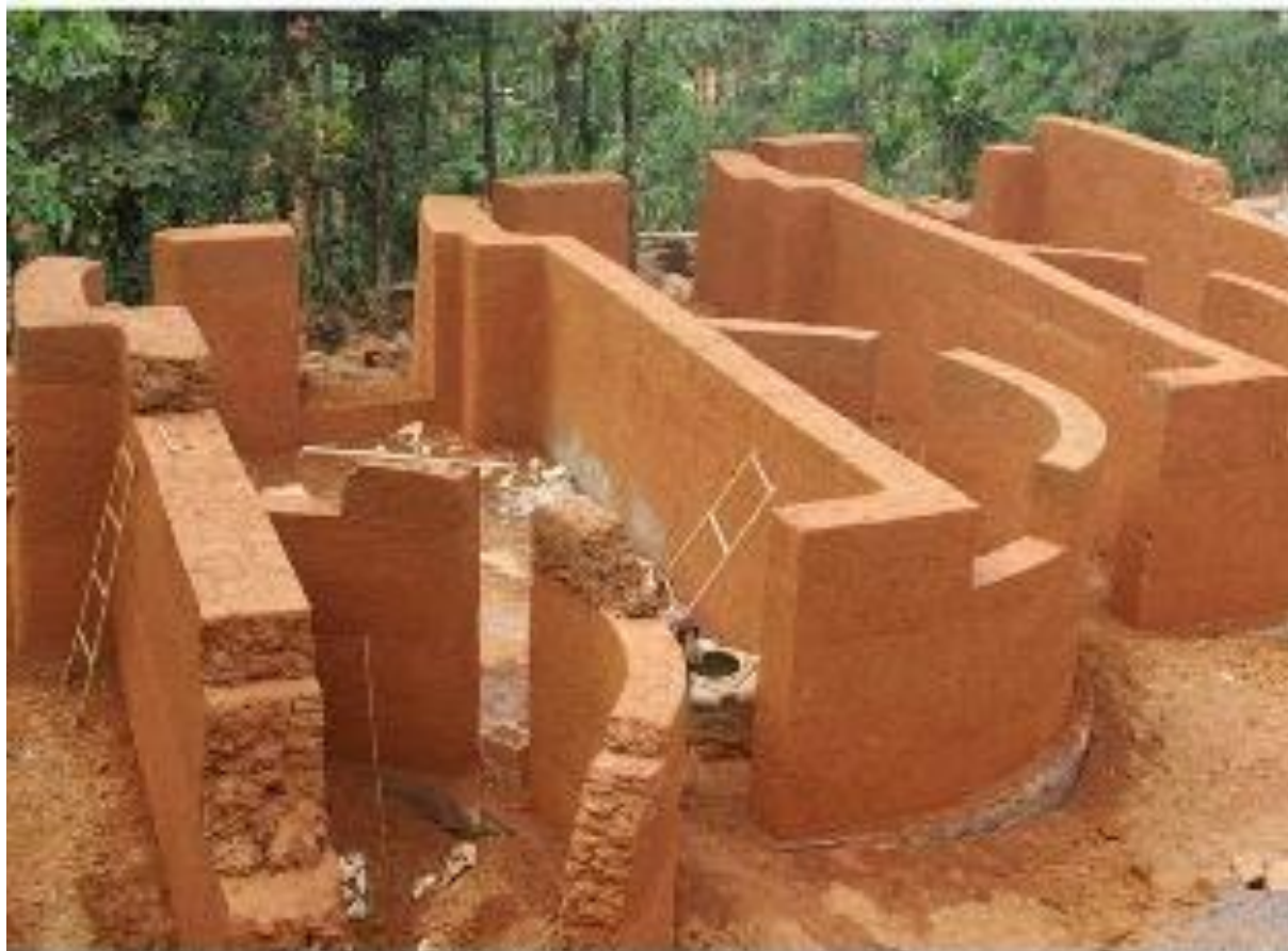
Рисунок 15.9 Строительство опорных конструкций и стен из землебита
