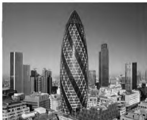
Рис. 5. Офисное здание «Мэри-Экс» в Лондоне, 2004 г.
