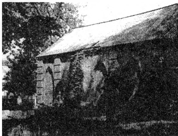
Рисунок 13 — Здание бывшего пожарного депо в Слониме
