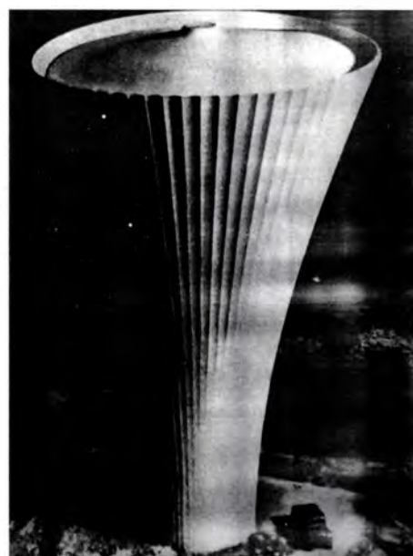
Рис. 20 Водонапорная башня построенная по принципу двух конусов инженер Р. Саржер Алжир 1964 г.
