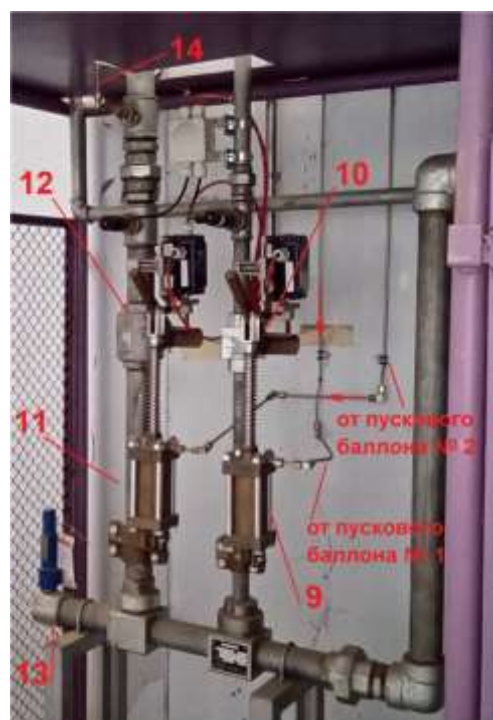
Рисунок 3. Секционные клапаны
