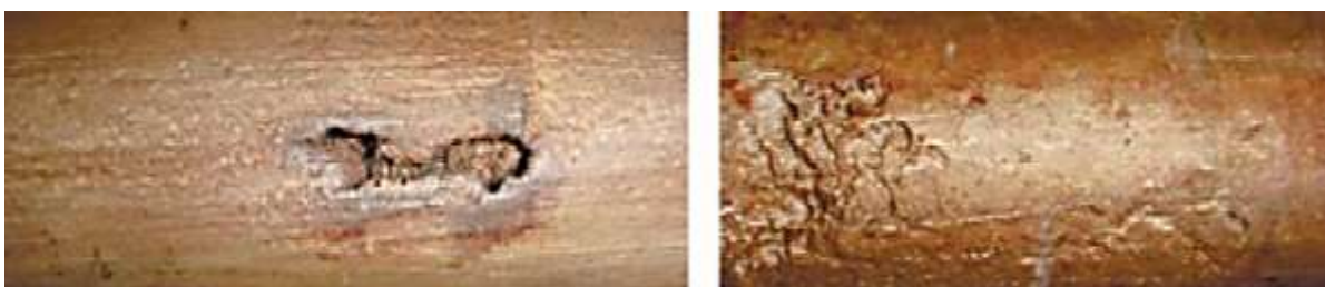
Рисунок 2. Утонение стенки теплообменных трубок: слева – протяженное наружное (сквозное) утонение; справа – локальное наружное утонение
