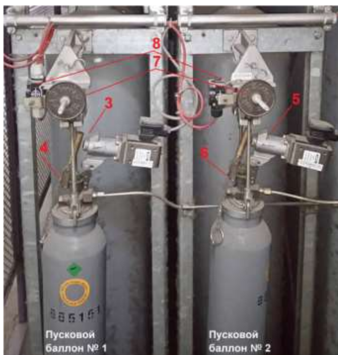
Рисунок 2. Пусковые баллоны
