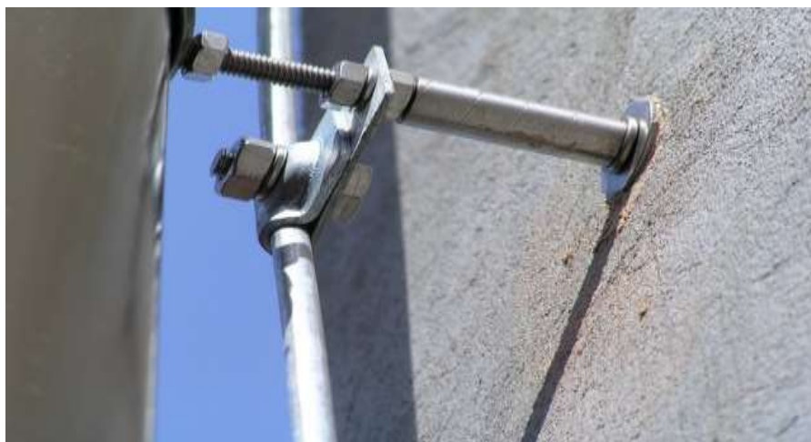
Рисунок 3. Соединение токоотвода с заземлителем
