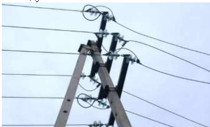
Рисунок 4. Разрядники на ВЛ 10 кВ
