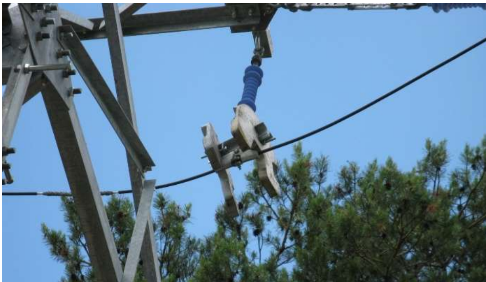
Рисунок 4. Крепление провода
