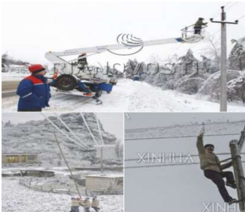
Рисунок 4. Механическое удаление отложения льда с проводов
