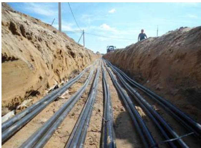
Рисунок 2. Прокладка СПЭ-кабеля
