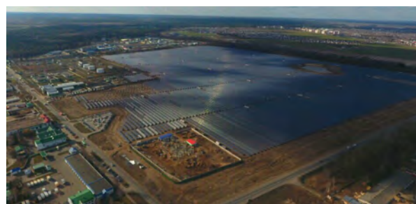
Рис. 4. Фотоэлектростанция в Речицком районе
