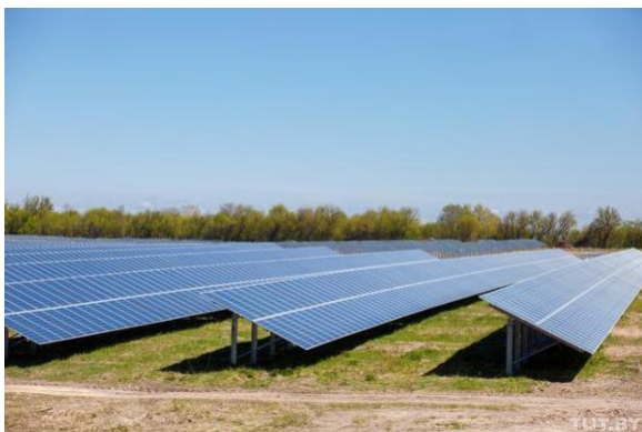
Рисунок 1. Брагинская ФЭС. Мощность солнечных батарей около 17 МВт
