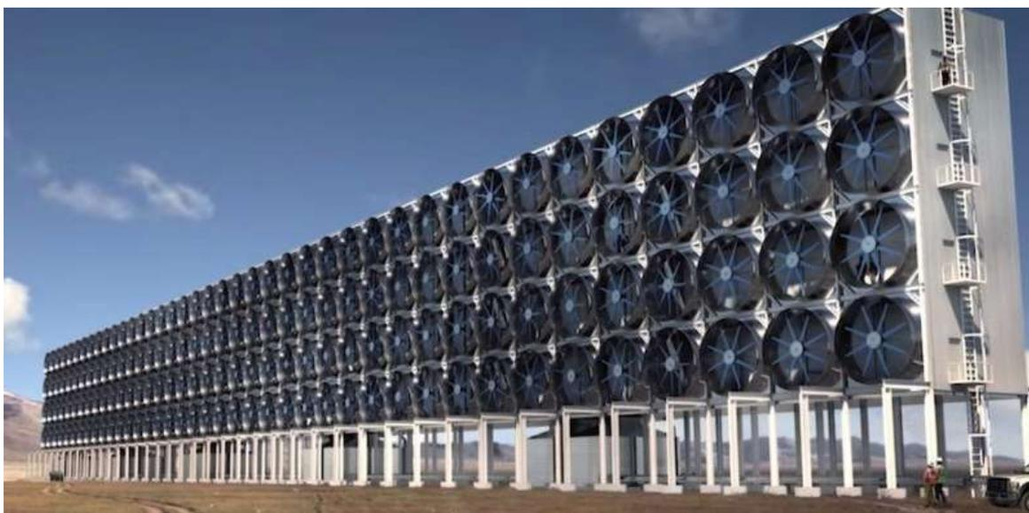
Рисунок 1. Установка прямого захвата воздуха
