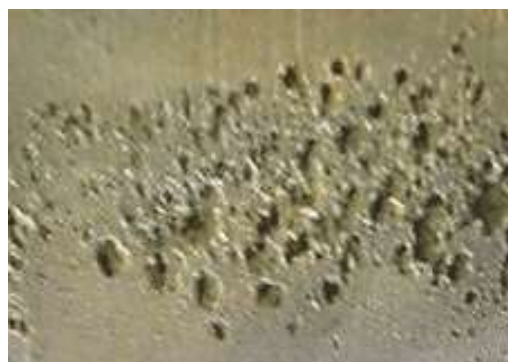
Рисунок 3 – Эрозионный износ стенки корпуса теплообменного аппарата
