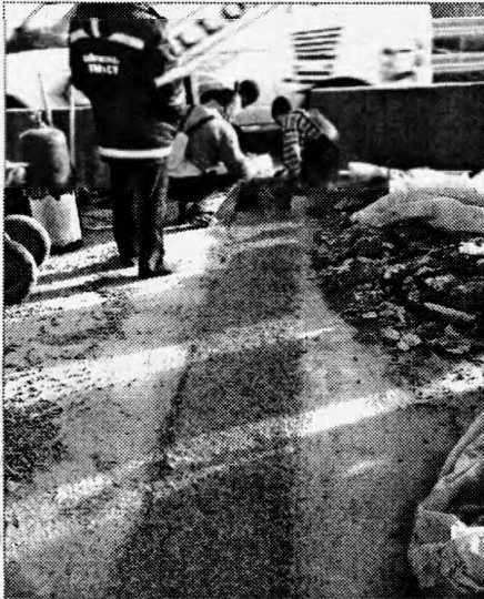
Рис. 12. Распределение горячей мастики с полимерным материалом по поверхности шва с последующей посыпкой горячим щебнем фракции 2,5–5,0 мм
