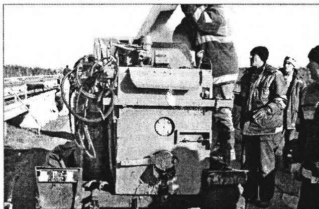
Рис. 10. Нагрев и перемешивание битумно-эластомерной мастики в котле с постепенным добавлением армирующего материала
