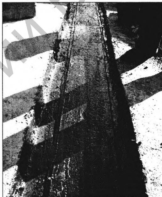
Рис. 9. Подготовка полости шва на путепроводе путем грунтовки его поверхности
