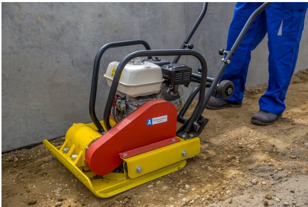
Рис.7.10 Уплотнение грунта с использованием виброплиты
