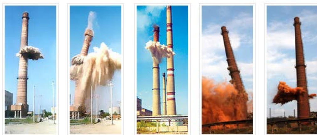
Рис.9.13 – Проведение взрывных работ
