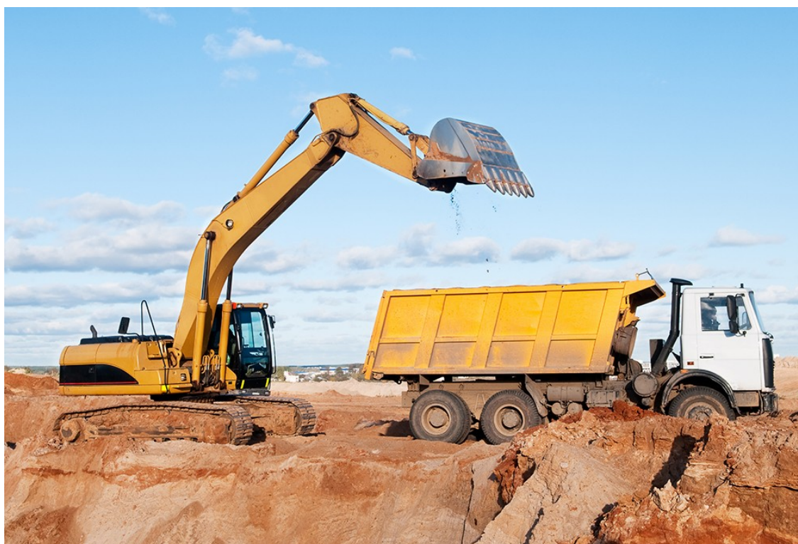
Рис. 6.8 – Погрузка грунта в автосамосвал
