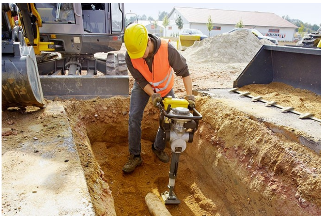
Рис.7.9 уплотнение грунта с использованием вибротрамбовки
