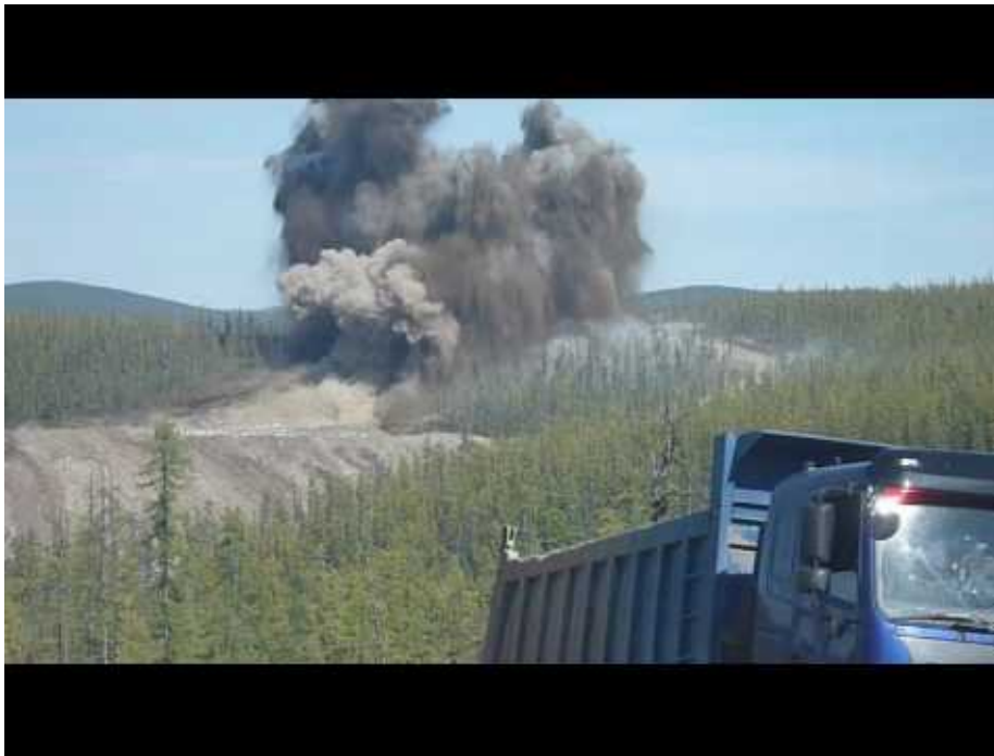
Рис.9.12 – Проведение взрывных работ
