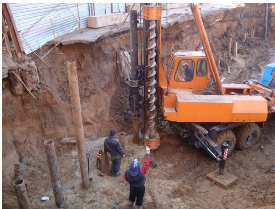
Рис. 8.7 - Шнековое бурение
