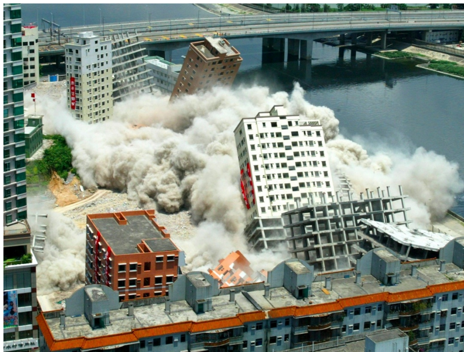
Рис.9.7 – Взрывные работы при сносе строений
