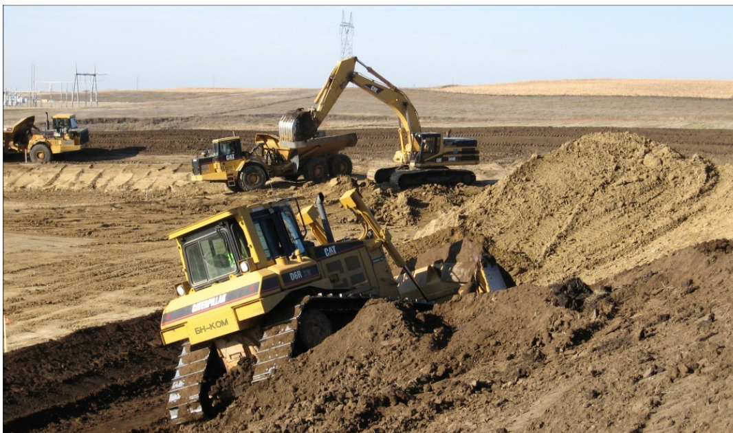
Рис.7.16 - Комплексная механизация земляных работ
