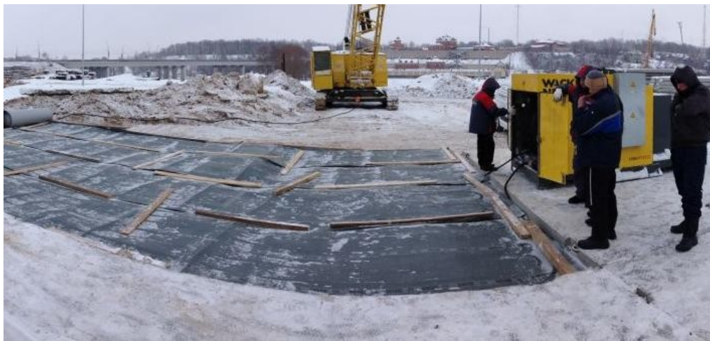
Рис. 10.3 - Оттаивание грунта электроматами
