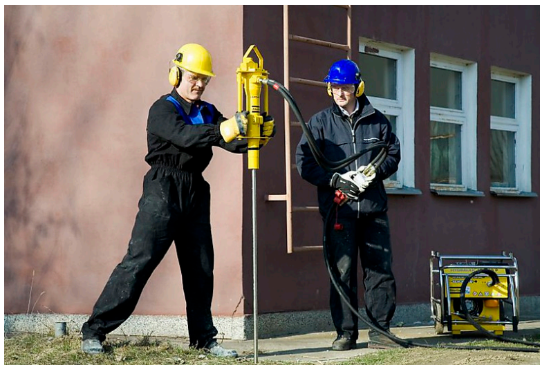
Рис.8.2 - Ударно-вращательное бурение
