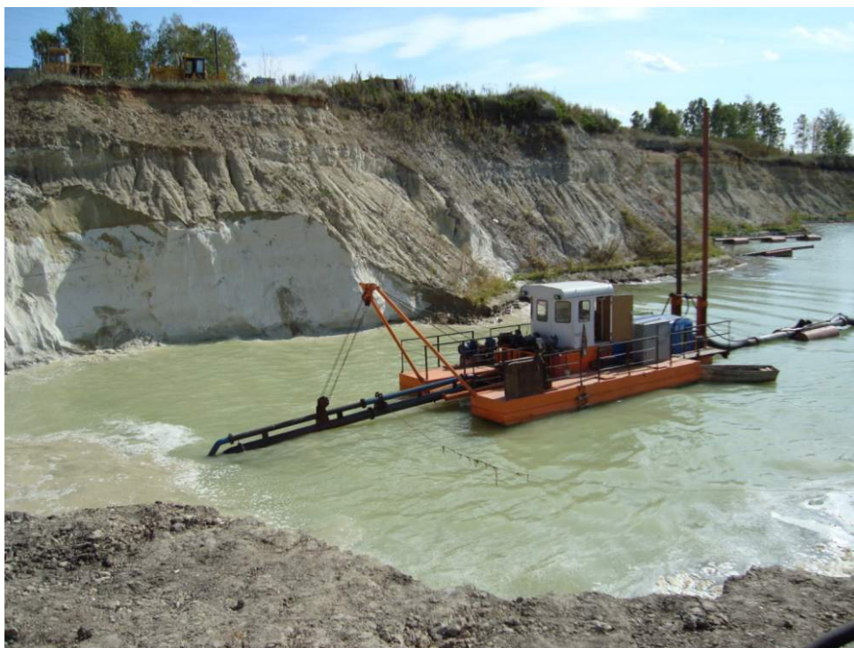
Рис. 9.2. Земснаряд (баржа) для землесосный разработки грунта
