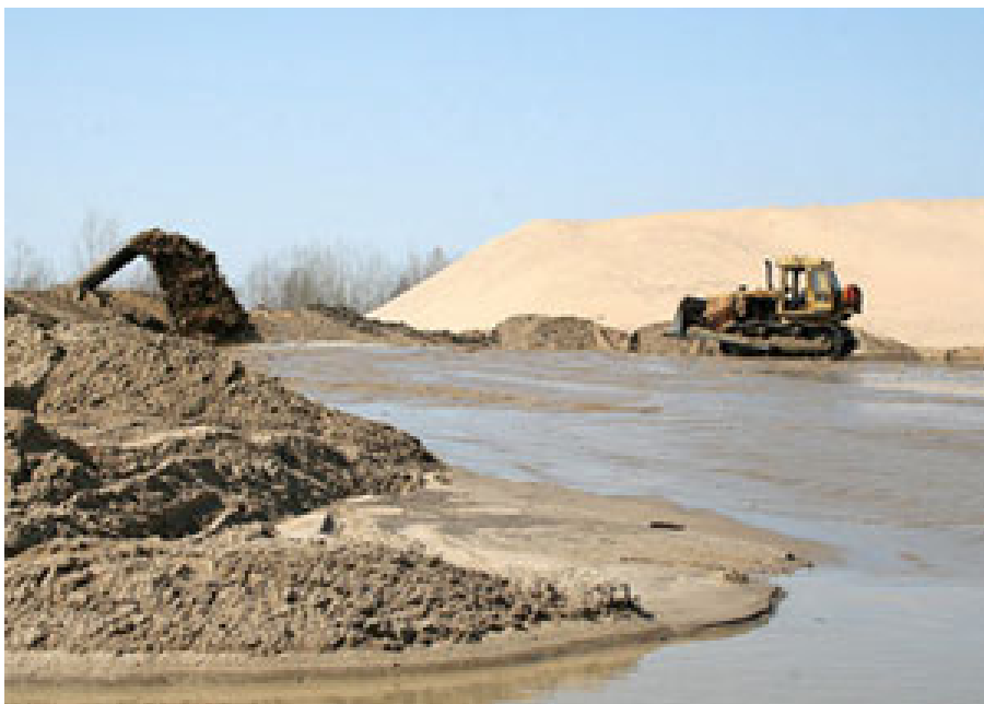
Рис.9.6 – Обваловывание карты намыва
