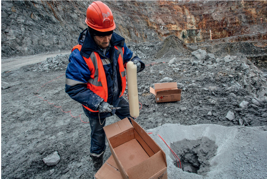
Рис.9.11 – Подготовка к проведению взрывных работ
