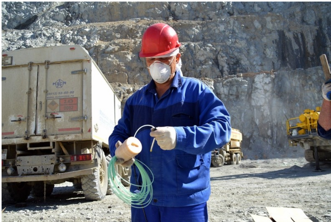
Рис.9.8 – Подготовка к проведению взрывных работ
