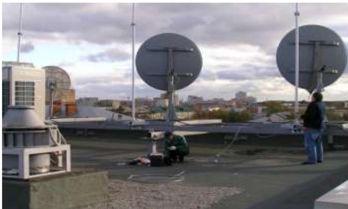
Рисунок 2. Установка молниеприёмников на крыше высотного здания
