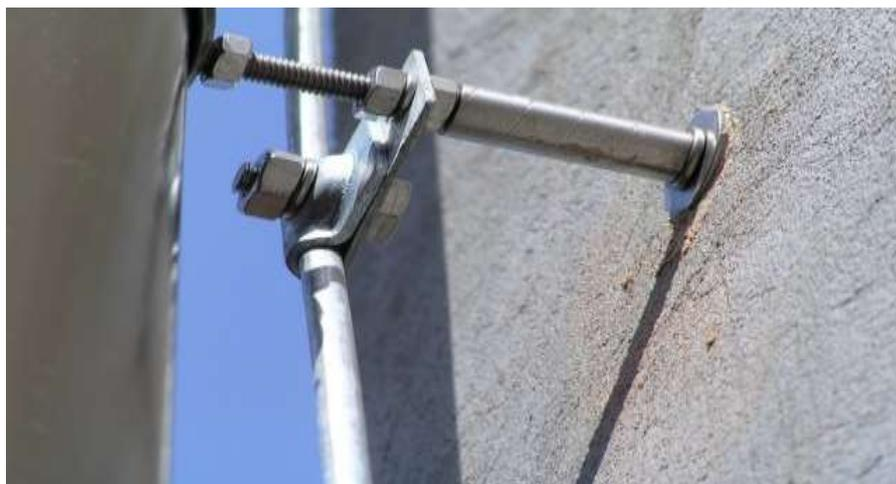
Рисунок 3. Соединение токоотвода с заземлителем
