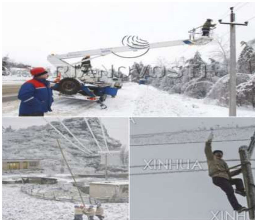
Рисунок 4. Механическое удаление отложения льда с проводов
