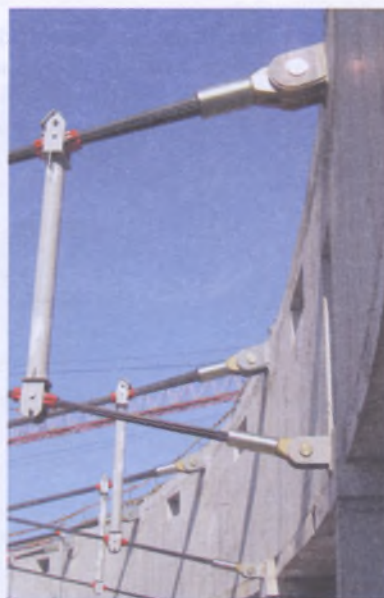
Рис. 5. Крепление вант к железобетонному кольцу
