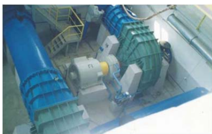
Рис. 2.158. Общий вид ковшовых и двукратных активных турбин
