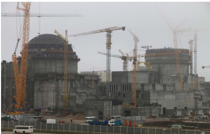
Рис. 1.28. Общий вид строительной площадки Белорусской АЭС
