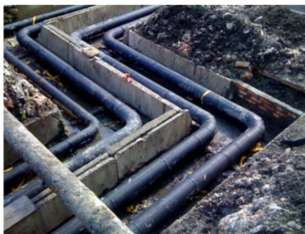
Рис. 1.35. Монтаж стальных ПИ-труб
