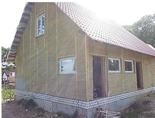
Рис. 4.70. Применение тростниковых плит в качестве теплоизоляционного материала
