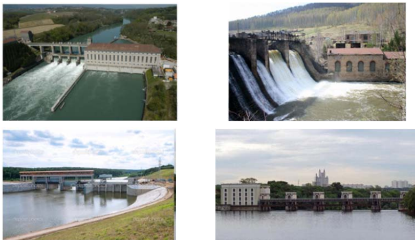
Рис. 2.150. Общий вид малых ГЭС с русловыми и приплотинными вариантами компоновки сооружений
