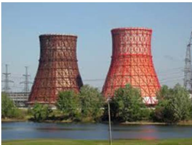
Рис. 6.7. Градирни и охлаждающие пруды теплоэлектростанций
