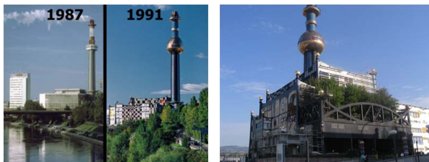
Рис. 2.182. Общий вид тепловой станции г. Вены, работающей на прямом сжигании отходов
