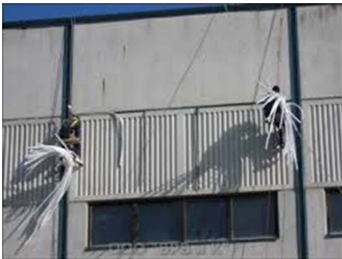
Рис. 4.55. Внешнее утепление производственных зданий
