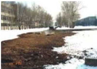
Рис. 1.38. Общий вид теплотрасс в зимнее время (источники тепловпотерь)
