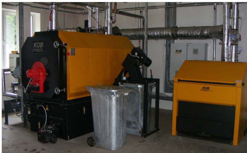
Рис. 2.168. Общий вид котлов фирмы КОВ (Австрия) для ротационного сжигания щепы ( a ) и сжигания дров ( б )
