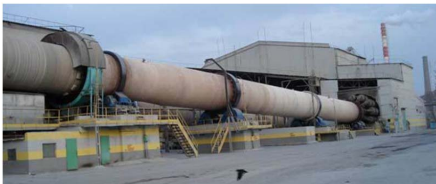
Рис. 4.11. Общий вид вращающейся печи цементного завода
