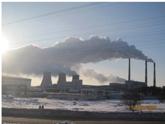
Рис. 6.5. Загрязнение окружающей среды отходящими газами (ТЭЦ-4, Минск)
