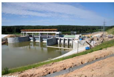
Рис. 2.148. Схема (а) и общий вид плотинной ГЭС без выхода подпорного уровня на пойму (б): 1 – здание ГЭС; 2 – водосбросная плотина
