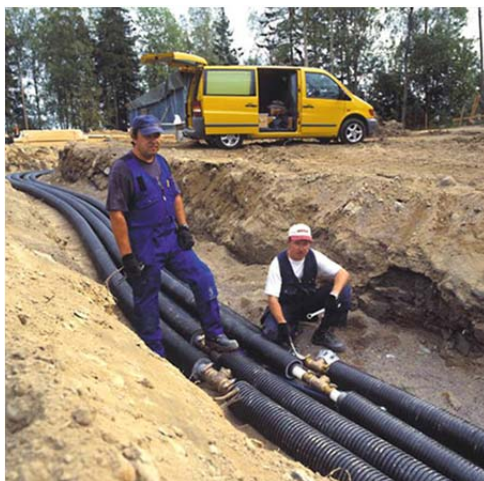
Рис. 1.37. Монтаж пластмассовых ПИ-труб
