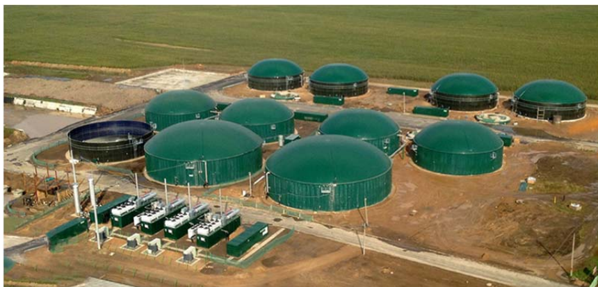
Рис. 2.175. Биогазовая установка СПК «Рассвет» имени К. П. Орловского, Могилевская обл., эл. мощность – 4,8 МВт, тепловая мощность – 5,2 МВт
