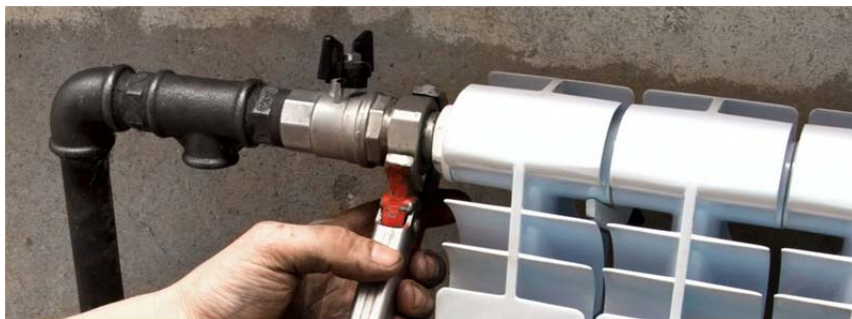
Рис. 4.83. Установка вентилей на отводах от подающего трубопровода к радиаторам
