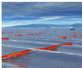
Рис. 2.130. Общий вид оборудования для использования метода «Аттенюатор». Pelamis волновая электростанция (Scotland) 4 сегмента – 750 кВт, длина – 150 м, ширина – 3,5 м
