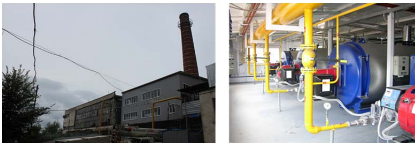
Рис. 1.23. Общий вид и оборудование районной котельной
