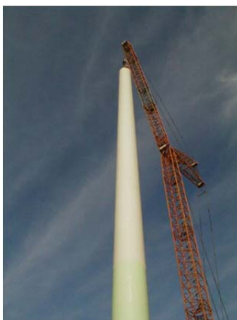
Рис. 2.61. Монтаж башни современной ВЭУ
