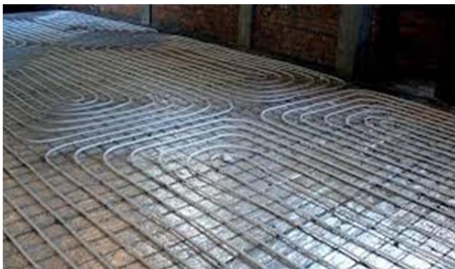
Рис. 4.53. Конструкция теплого пола
