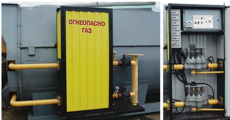
Рис. 4.46. Общий вид шкафа для регулирования газа на предприятии
