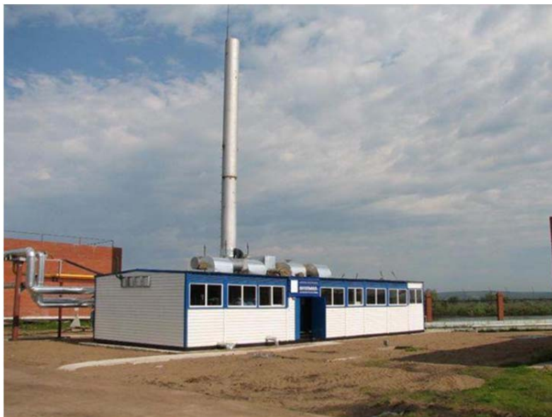
Рис. 1.22. Блочно-модульная котельная: а – конструкция; б – общий вид
