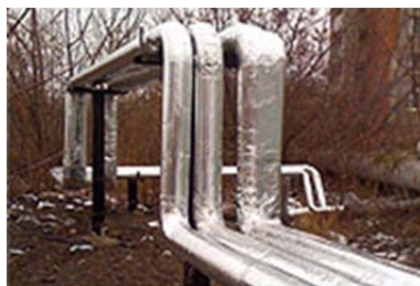
Рис. 1.39. Дополнительные источники теплотерь на теплотрассах
