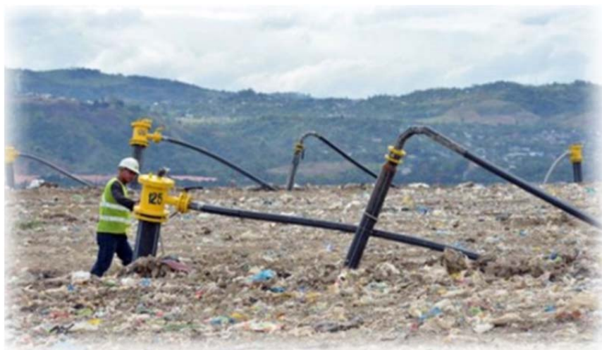
Рис. 2.178. Общий вид полигона ТБО с системой сбора свалочного газа
