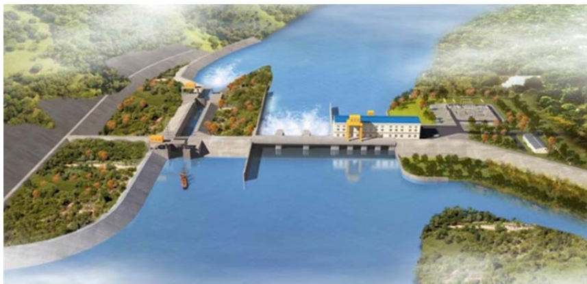
Рис. 2.144. Панорамный вид Витебской ГЭС
