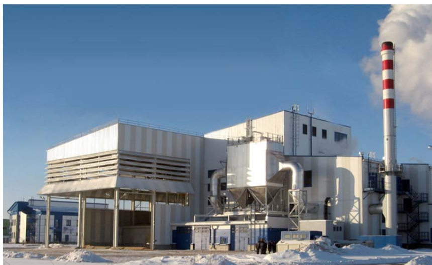
Рис. 2.172. Общий вид мини-ТЭЦ г. Пружаны, 3,7 мВт (топливо – древесная щепа)
