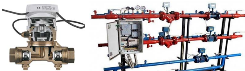
Рис. 4.31. Общий вид датчиков расхода и их установка в теплотехнических системах
