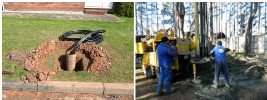
Рис. 2.110. Бурение скважин под геотермальные зонды
